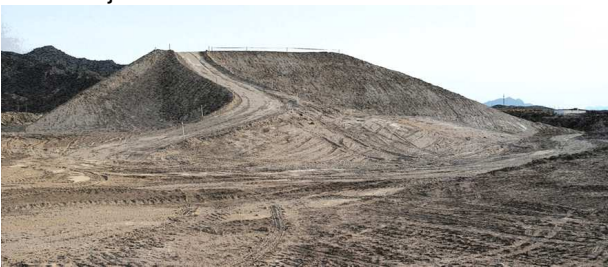
Fig. 1. Aspecto del terraplén de prueba
